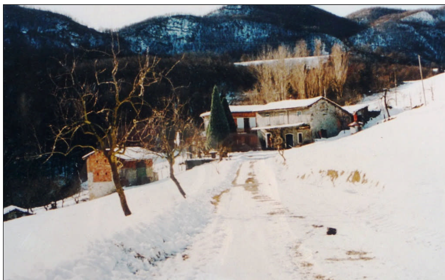
Foto invernale dei fabbricati del mulino prima della ristrutturazione [Gentilmente concessa dagli attuali proprietari]
