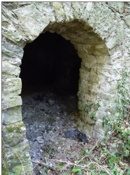
Il vecchio scarico della acque
